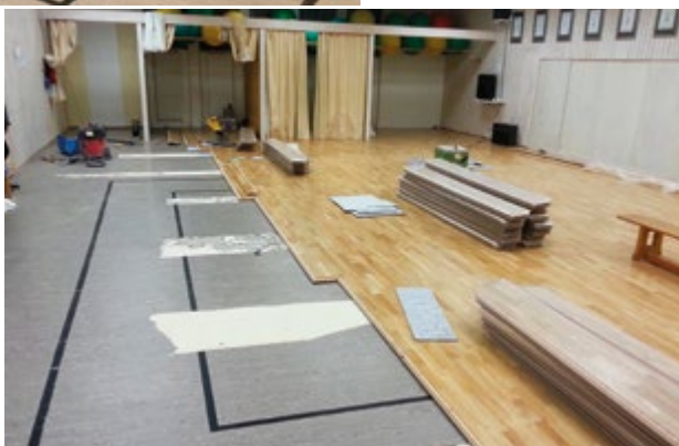
Der Weg zum neuen Hallenboden
